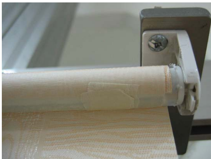
Рис. Выравнивание ткани путем наклеивания скотча
