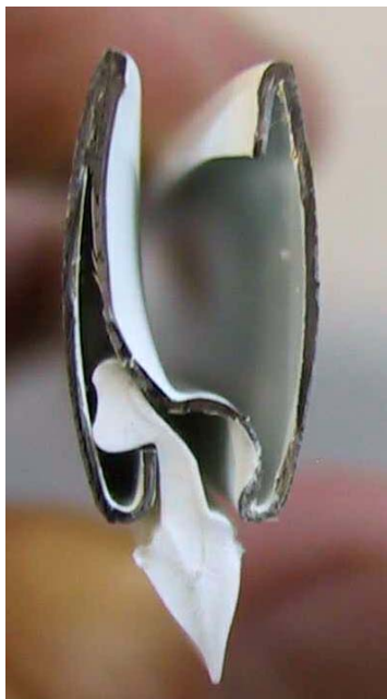
Рис. Вставка уплотнителя в нижнюю планку
