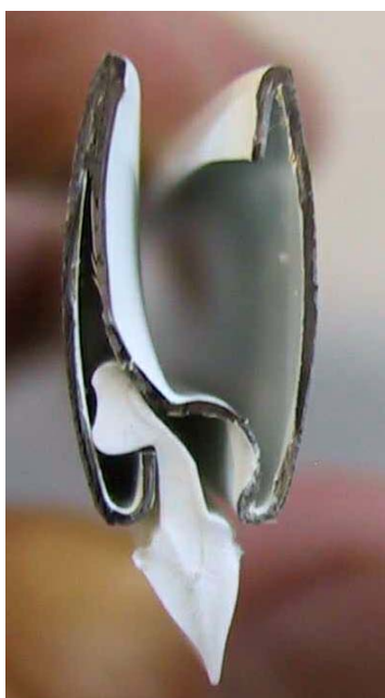
Рис. Вставка уплотнителя в нижнюю планку
