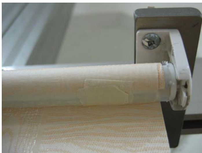
Рис. Выравнивание ткани путем наклеивания скотча
